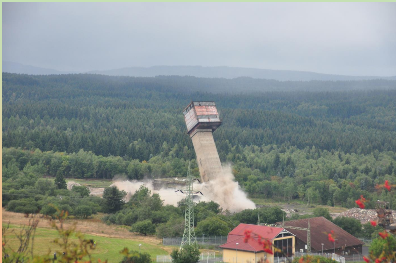
Sprengung des Förderturmes in Měděnec/Kupferberg
